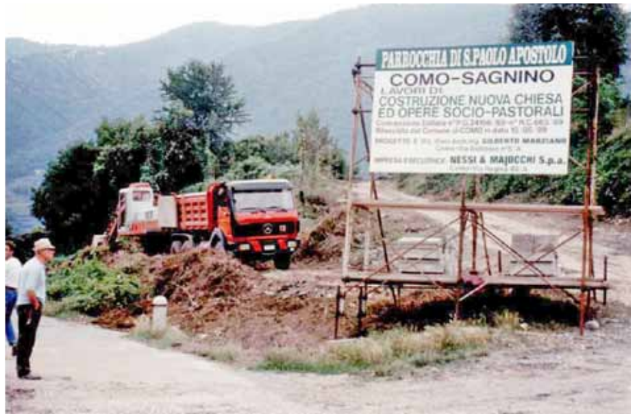
10 luglio 1989 cartello di cantiere e inizio lavori di scavo e sbancamento.
