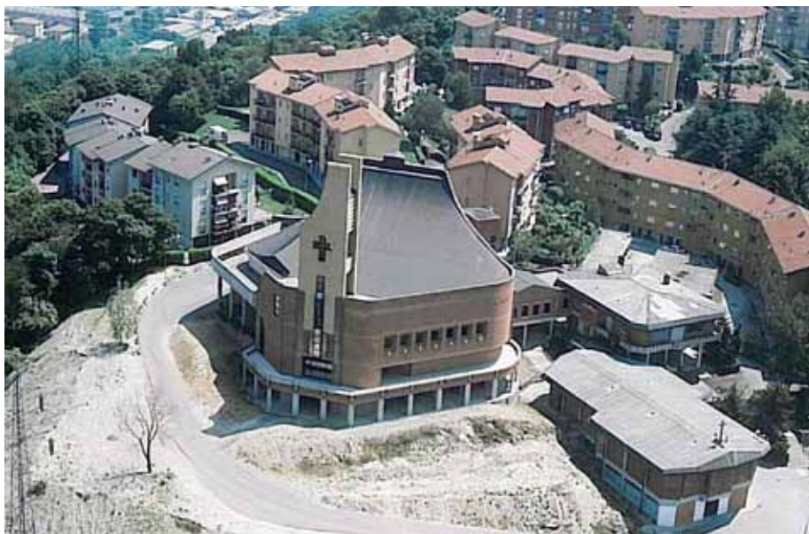
Una veduta aerea della chiesa nuova a fine cantiere costruzione.
